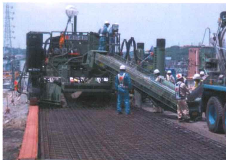
コンクリート舗装の溶接金網工法概念図 コンクリート打設時に内部にメッシュ（鉄網）を敷設、一体化させる。進行方向の目地にはダウエルバー、横（幅員）方向の目地にはタイバーを配し、ブロック間の段差発生を防ぐ。
