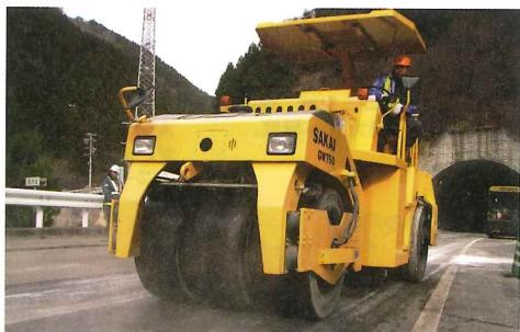
タイヤローラ(振動ローラ)の締固め作業風景。タイヤローラの多くはバラスト(水タンクなど)により、荷重を変化させることができる。
