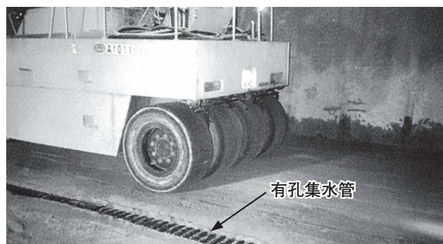
図 9 水砕スラグ路盤施工状況
