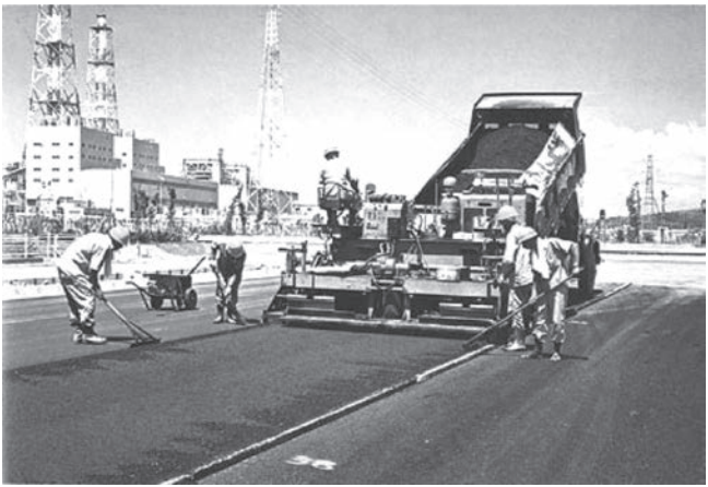
図7 鉄鋼スラグをアスファルト混合物用骨材として用いた施工例 16)
