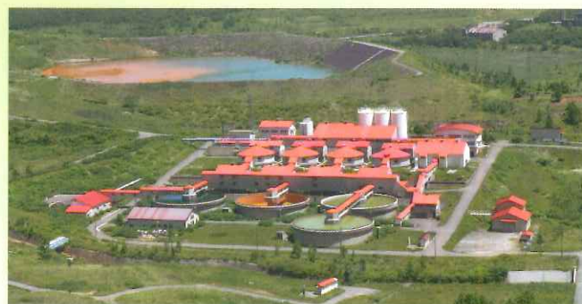
鉄酸化微生物を活用した旧松尾鉱山新中和処理施設 資料提供: (独)石油天然ガス・金属鉱物資源機構
