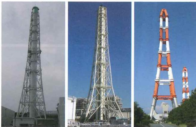
東京電力福島第一原子力発電所5、6号排気筒（高さ120m）。鋼製1筒（独立型）鉄塔支持型。構造は煙突と変わらないが、原子力発電所で建屋内の換気を目的に設置されるものを「排気筒」と呼ぶ。
