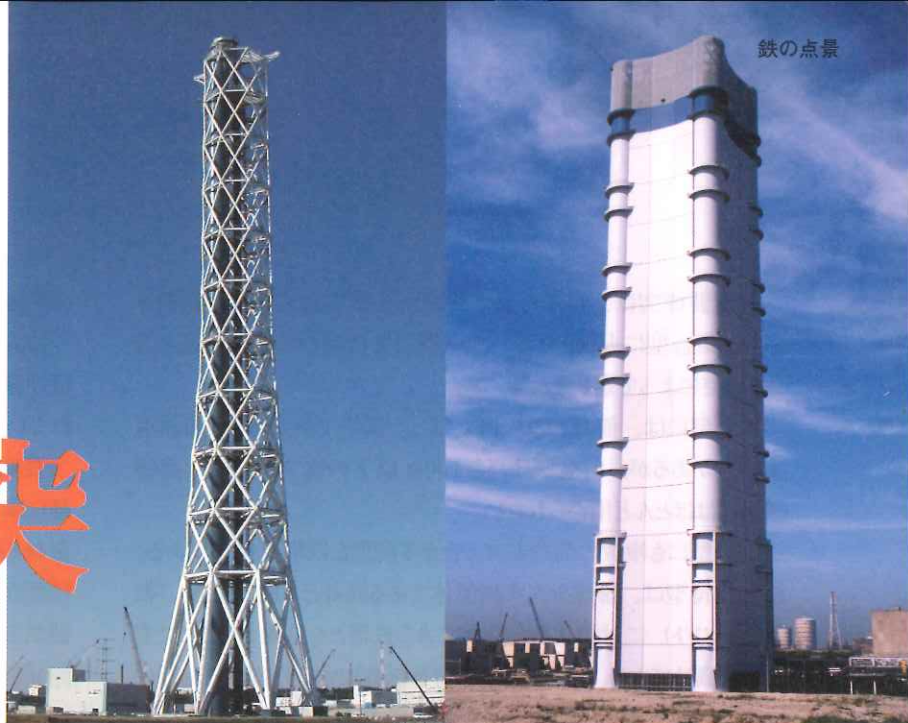
〔写真左〕東京電力常陸那珂火力発電所 1 号煙突（高さ 230m）。景観に配慮した鋼製鉄塔支持型。青色の筒身と白色の八角クロスバイラル型の鉄塔からなり、夜間はライトアップされ「常陸那珂レインボータワー」の愛称ももつ。1 本目の筒身は鉄塔内でオフセットしており、この後筒身が追加されて集合型となる予定。〔写真右〕東京電力富津火力発電所 3、4 号煙突（高さ 150m）。外側配置の 4 筒身と内側配置の 3 筒身、計 7 筒身の鋼製多脚型で、煙突間を外装鋼板で覆い、形状、色彩を周辺環境となじませて景観に配慮している。
