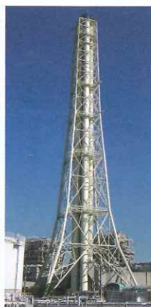
鋼製 4 筒集合型・鉄塔支持型煙突。東京電力姉崎火力発電所 1、2 号煙突（高さ 200m）。
