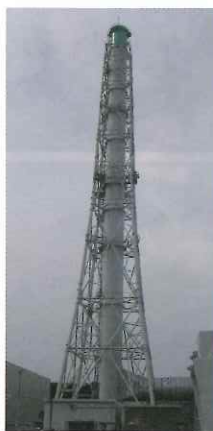
東京電力福島第一原子力発電所 5、6 号排気筒（高さ 120m）。鋼製 1 筒（独立型）鉄塔支持型。構造は煙突と変わらないが、原子力発電所で建屋内の換気を目的に設置されるものを「排気筒」と呼ぶ。
