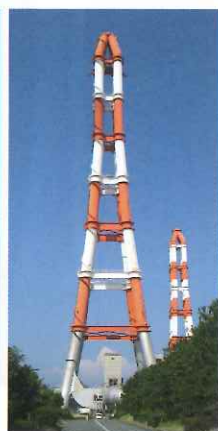
鋼製 4 筒集合型・多脚型煙突。中部電力渥美火力発電所 3、4 号煙突（高さ 200m）。
