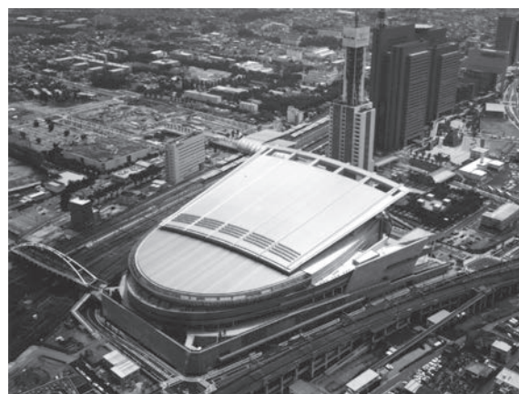
図 11 特殊クリアー塗装高耐食フェライト系ステンレス鋼板の施工例 (埼玉スーパーアリーナ)
