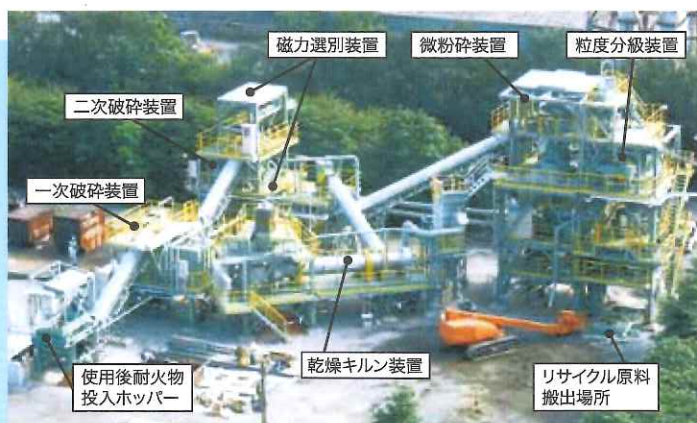
使用済み耐火物の破碎・粉砕プロセス(新日本製鉄(株)大分製鉄所)
