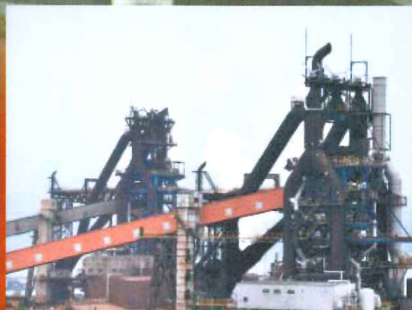
高炉炉底部の耐火物改修工事(上)、改修後の高炉(下)
