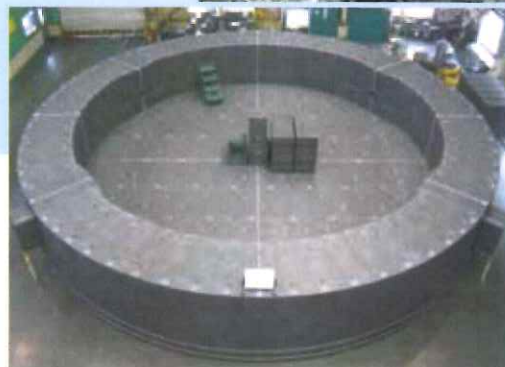
炉底部での耐熱れんがの工事のようす(上)、仮組みされたカーボンブロック(1段分)(下)
