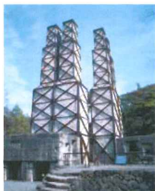
1853年に建設された反射炉(伊豆・韮山)。高さ約15mの炉の内部は耐火れんが積みでできている。(写真提供:伊豆の国市)
