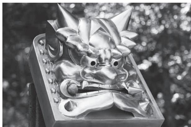
図8 浅草寺宝蔵門に使用された高プレス成形性極低酸素純チタン(SuperPureFlex<sup>®</sup>)製鬼瓦
