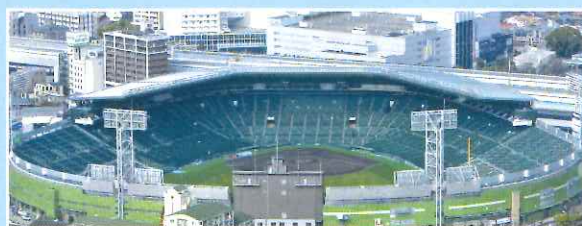
2009年に新装となった阪神甲子園球場の銀傘には、耐食性にきわめてすぐれた55%アルミニウム-亜鉛合金めっき鋼板が用いられている。 （写真提供：読売新聞社）
