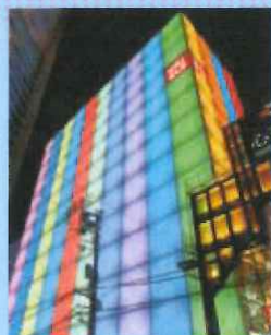
LED照明によってカラフルな外観を変化させることができる。 (写真提供: (株)ユニクロ)
