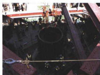
底面三角形の頂点部分の基礎杭と柱とを接続する部分。
