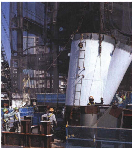
地上部塔体の三角形平面の頂点の元にあたる鉄骨の取付工事（2009年4月6日）。この鉄骨は高さ約4m、幹部分の直径は2.3m、厚さ10cmで、重さは約29tある。
