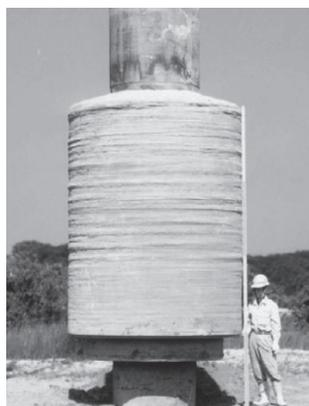
図2 拡大根固め部
