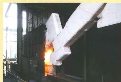
補修マニピュレータが炭化室に入るようす(試験運転時)
