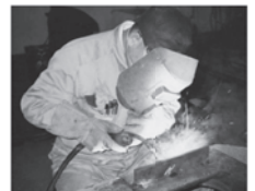
溶接状況 (半自動溶接)
