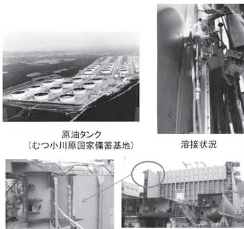
図28 エレクトロガス溶接 (EGW) の適用例
