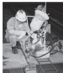
溶接状況 (工場板継溶接)
