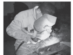
溶接状況 (半自動溶接)
