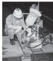
溶接状況 (工場板継溶接)
