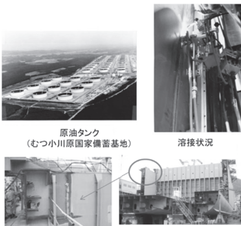
図28 エレクトロガス溶接 (EGW) の適用例
