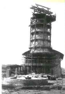
東田第一高炉(建設中、1900.4) 写真提供：新日本製鐵(株)
