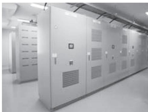
写真3 50kW蓄電池システム
