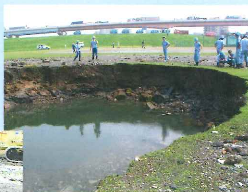
野球グラウンドが大きく陥没した
