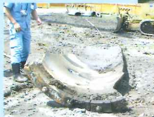
破裂した水道管の破片
