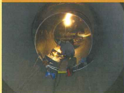
老朽化した既設管の中に新設管を送り込み溶接している
