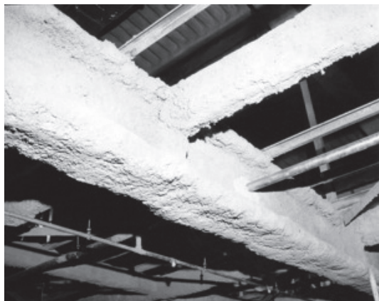
写真1 吹き付けロックウール
