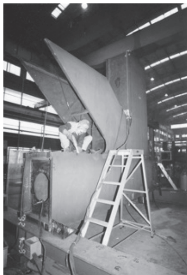
写真9 P&Gビル、柱-梁接合部溶接試験
