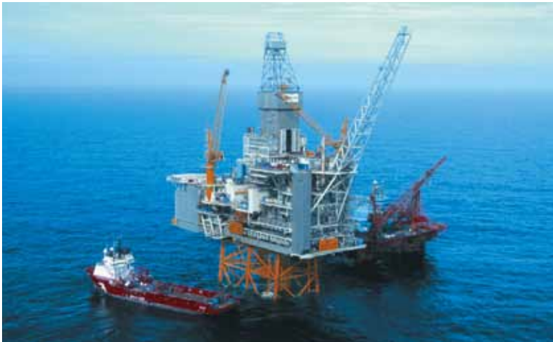
ノルウェーのOseberg油田で、1984年に初めてTMCP鋼を適用したプラットフォームが建設された。同油田には複数のプラットフォームが存在しており、写真は1998年にTMCP鋼が適用されたプラットフォームのOseberg Southである。
