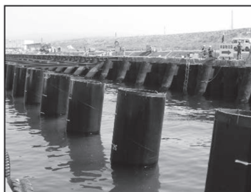
図11 ポリエチレン被覆鋼管杭の施工例
