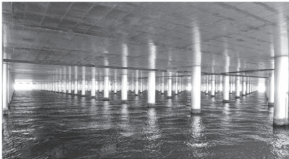
(b) レグ部への耐海水性ステンレス鋼被覆
