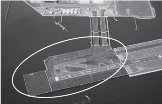
(a) 羽田空港 D 滑走路 栈橋部
