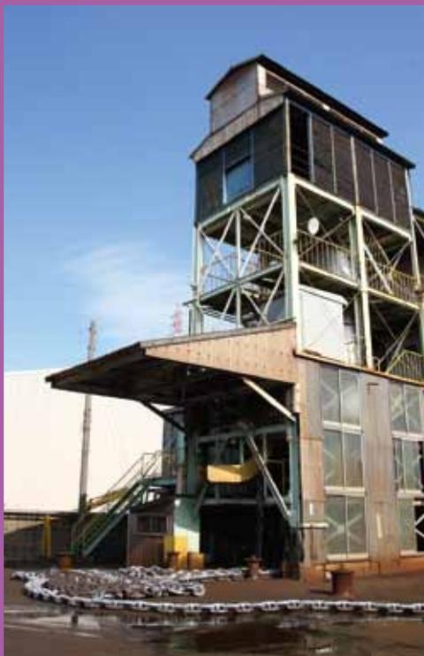
熱処理工場に入っていくチェーン。焼入れ炉と焼戻し炉が連続して設置されている。なお、工場敷地内の地面は、チェーンの表面に傷がつきにくくするため、ほとんどが鉄板で覆われている。
