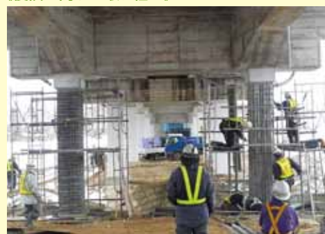
新花巻～盛岡間 高架橋応急工事
