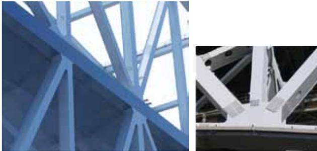
全溶接されたトラス格点(左)と従来のトラス格点(右)。東京ゲートブリッジのトラス格点は、全溶接を採用することで、ボルト集中部への雨水の堆水などを防止し、腐食環境の緩和と維持管理コストの縮減を実現している。(資料提供:新日本製鐵(株))
