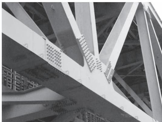
写真2 一般的トラス橋格点部
