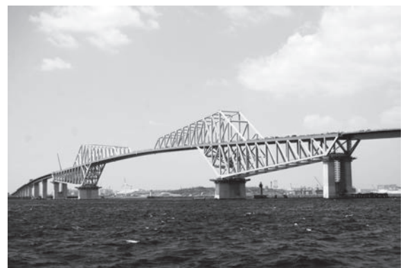
写真5 東京ゲートブリッジ
