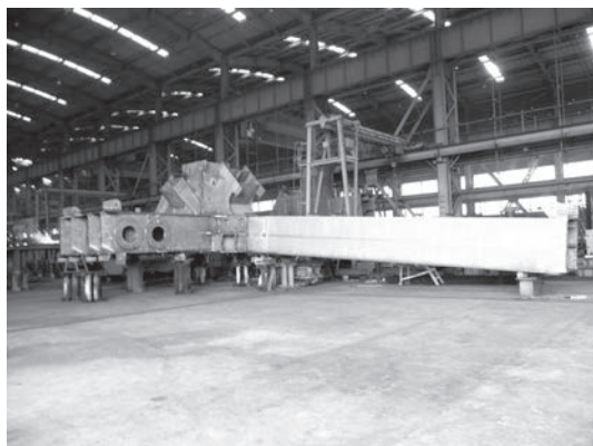
写真7 工場製作状況
