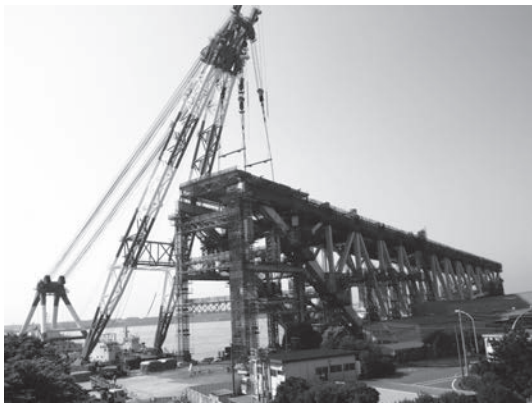
写真9 地組立鋼床版載架作業の様子
