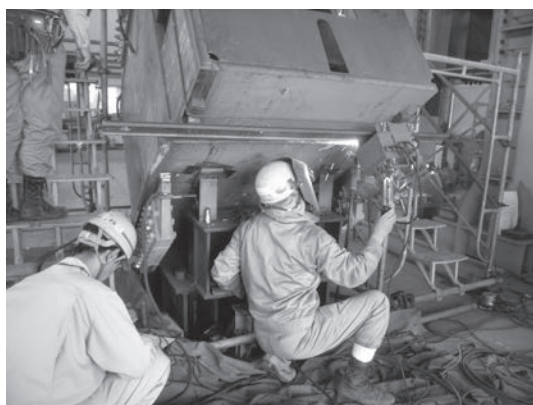
写真6 溶接施工試験状況
