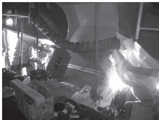
写真8 地組立現場溶接の状況
