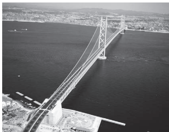
写真2 明石海峡大橋(兵庫県)
