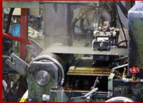
冷間圧延では、熱延コイルから数回に分けて所定の厚さまで圧延する。圧延中は板厚計測装置により厚さのデータをフィードバックし、最適条件に制御する。
