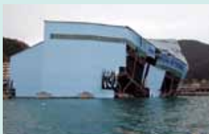
津波により荷役中だった大型船が激突し、半壊した全天候バース。
