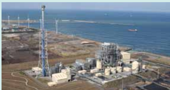
CO 2 低減のため、製鉄所内で発生する廃木材や缶コーヒーメーカーから譲り受けたコーヒー粕を燃料の一部として使用するバイオマス混焼を行っている。
