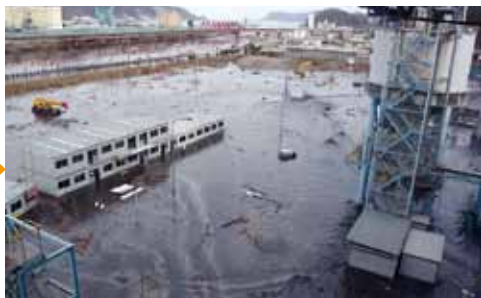
発電所敷地内浸水(GL+50cm)
