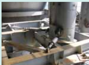
切断された防振ダンパー
