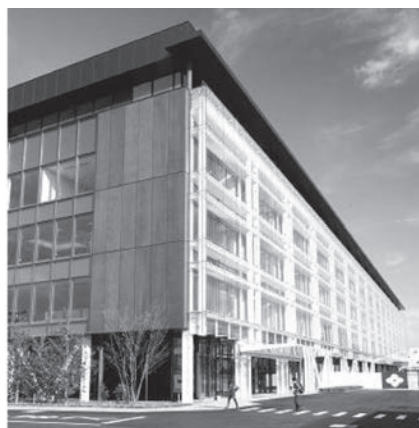
図1 新研究棟建物外観
