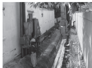
写真1 シンガポールにおける施工事例
