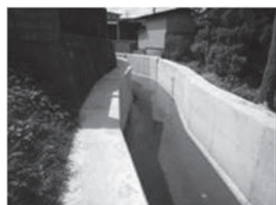
写真2 (b) 施工後の水路状況
