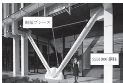
図2 「SSS1000」と制振デバイス
