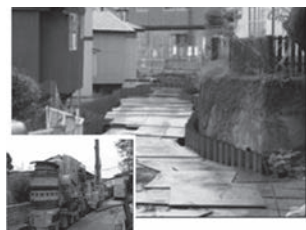
写真2 (c) SM-J パイルの施工状況
