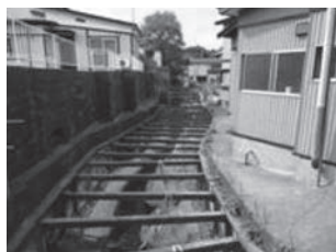
写真2 (a) 施工前の水路状況
