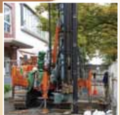
南河原こども文化センターの鋼管杭およびヒートポンプの構成
