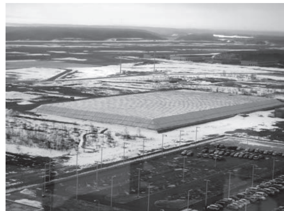
写真1 遮熱シート敷設後の貯雪ピット雪山
