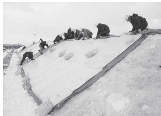
写真2 遮熱シート敷設作業
