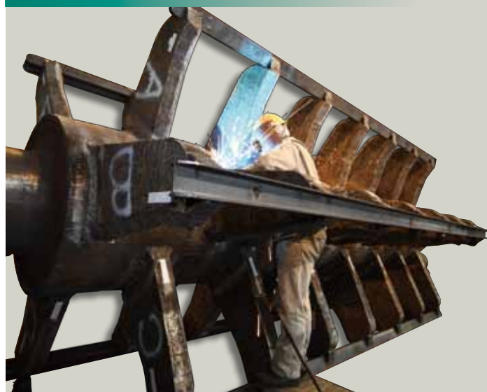
人間よりも巨大なクラッシャーの回転部分である「鬼歯」の補修作業のようす。
