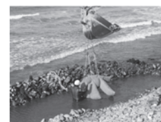
写真5 ユニット施工状況
