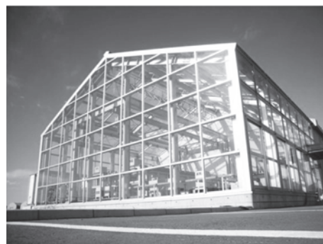
写真8 総合技術センター シーラボ設備
