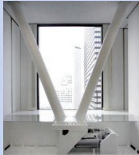
新宿センタービルに設置されたダンパー。柱や梁、基礎など既存の構造に負担をかけないよう、大きな力がかかると減衰力が小さくなる変位依存型オイルダンパーを用いた構法が採用された。
