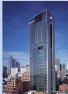
代ゼミタワー。積層ゴムとオイルダンパーを使用したセミアクティブ免震装置を採用。建物の揺れをセンサーで検知し、最も揺れを抑える最適減衰力をコンピュータで計算し、オイルダンパーを制御している。3.11時は通常通り講義が行われていたという。
