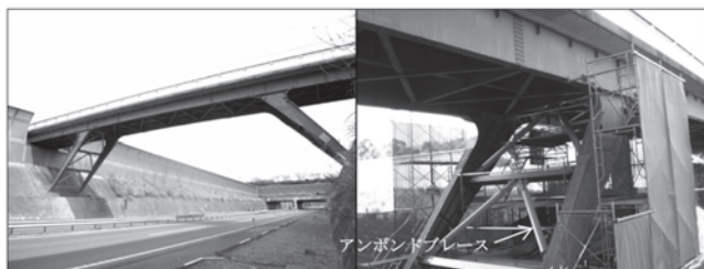
写真2 アンボンドブレース適用事例 (橋梁耐震補強)
