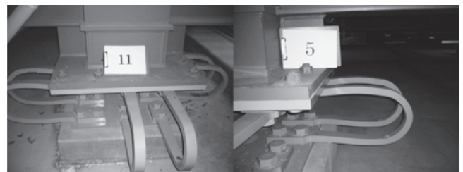
写真8 I病院抜き取り試験対象
