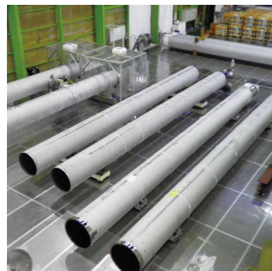
ダクトとベローズの溶接作業の様子 写真提供：(株)ミラプロ、野田工場
