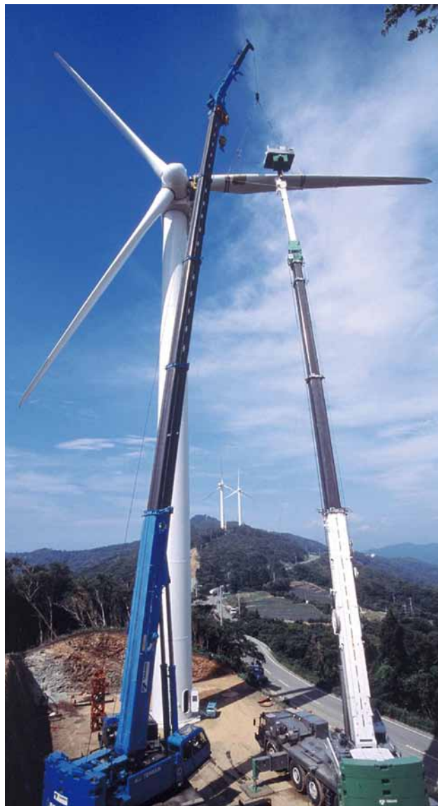
最近では、風力発電の風車の建設などで大型クレーンの需要が高まっている（ブーム長さ約80～100m）。これに応えるためさらに高強度化が進むことが予想される。
