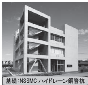
図1 共英製鋼開発センター兼避難ビル
