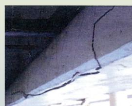
主桁下部のひび割れ箇所の例
