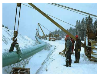
長距離にわたり敷設されるパイプライン (写真提供：JFEスチール(株))
