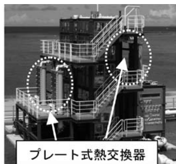
図1 海洋温度差発電実証機と熱交換器
