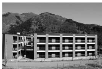
図1 釜石市上中島復興公営住宅
