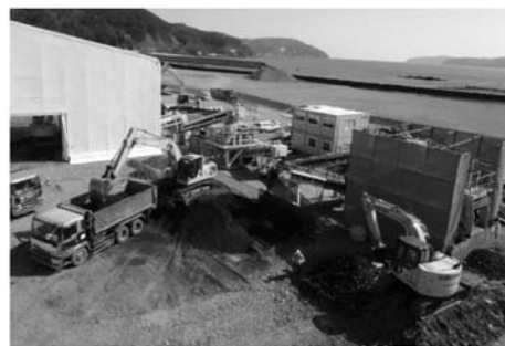
図 カルスピン ® 工法の全景 (釜石市災害廃棄物処理事業)
