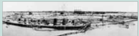
川崎製鉄建設中の千葉製鉄所(1950年当時) *9
