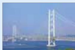
高強度な線材が大量に採用された 明石海峡大橋 *16
