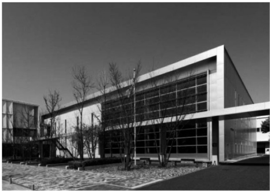
図5 大林組・技術研究所オープンラボ2 (画像提供 大林組)
