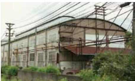
**旧鍛冶工場** 修繕工場と同様に、1900(明治33)年にグーテホフメクスヒュッテ社の設計・鋼材で建設された。当時としては大型の350t水圧プレス機械などが設置され、製鐵所建設に必要な鍛造品が製造された。(写真提供:新日鐵住金(株))
