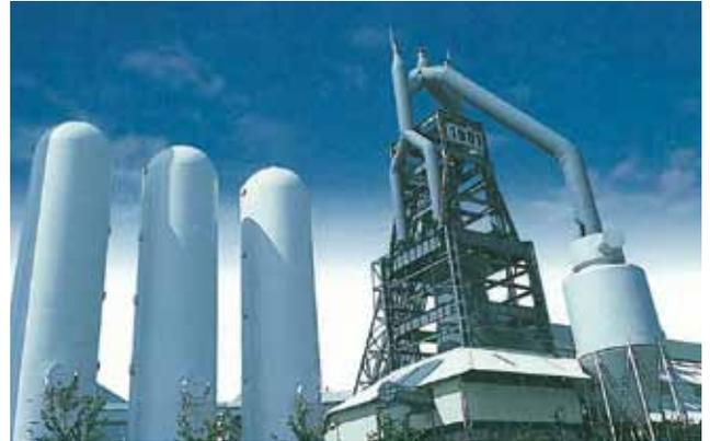
**東田第一高炉跡** 当初は高さ30m、日産160tであったが、現存する第10次改修高炉は高さ70m、日産900tを誇った。1962(昭和37)年8月から1972(昭和47)年1月まで操業し、超高圧高炉時代の先鞭をつけた。(写真提供:新日鐵住金(株))
