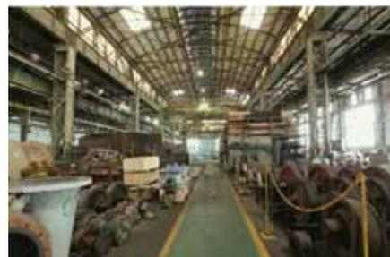
**修繕工場** 1900(明治33)年にグーテホフメクスヒュッテ社の設計・鋼材で建設された。現存する鉄骨建築物としては国内最古で、100年以上経った現在も修繕工場として稼働している。(写真提供:新日鐵住金(株))
