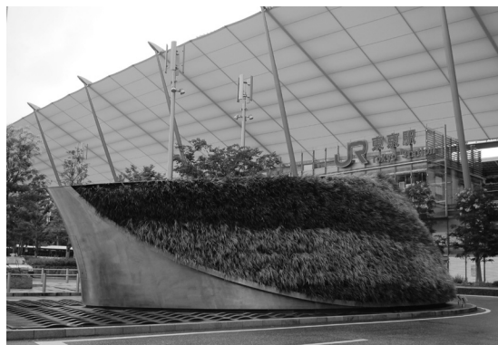
図11 二相系ステンレス鋼の構造物への適用例：東京駅八重洲の換気口施設 (写真提供：新日鐵住金ステンレス (株))
