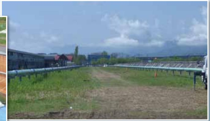
石狩プロジェクトでは、太陽光発電所からデータセンターへ送電する500 mの「回線1」(写真左)と、将来の長距離化に向けた冷却循環やケーブル接続技術の検証をする1,000 mの「回線2」(写真右)が建設された。
