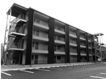
図2 4階建てスチールハウス
