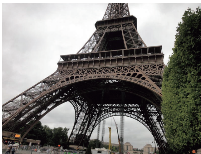
図1 錬鉄製のエッフェル塔。耐候性鋼を連想させるが、表面は塗装されている
